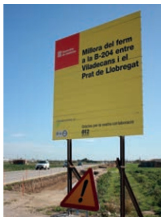
Inicio de las obras de la B-204
