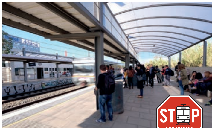
Un tren pasa de largo por la estación de Viladecans
