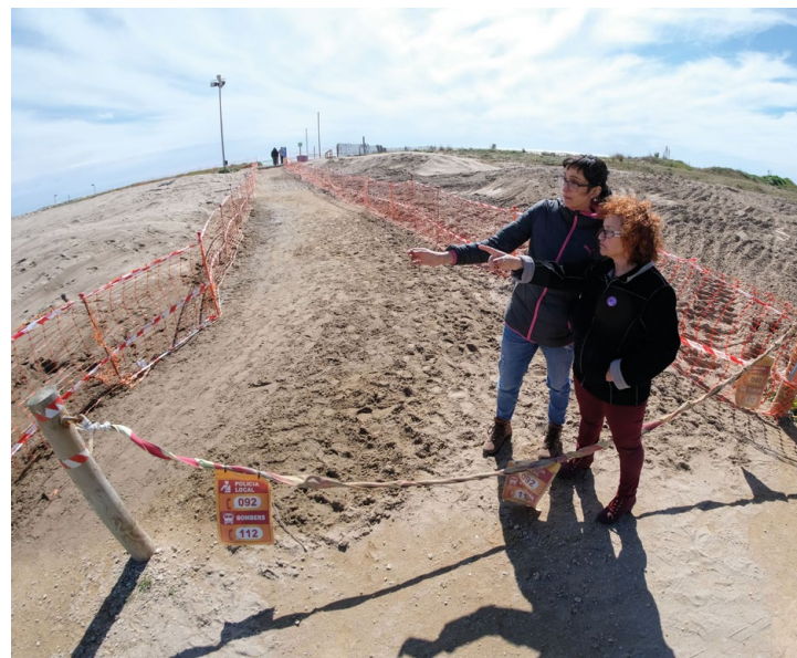
La concejal de Medio Ambiente visita las obras de adecuación
