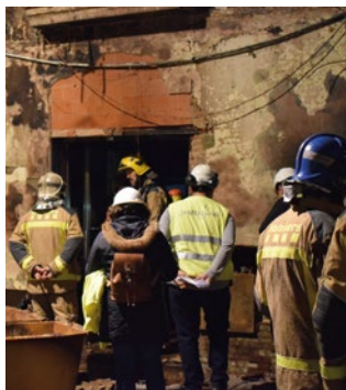
Façana del comerç afectat
