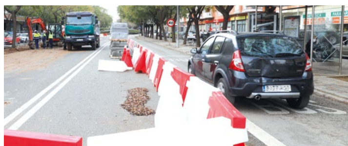
Les obres deixen un carril per sentit a la via al llarg de 800 metres
