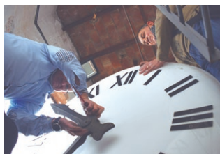
Treballs de reparació del rellotge
