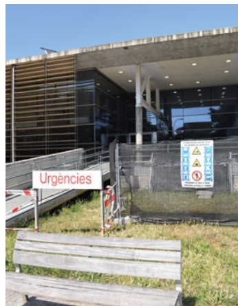
Edificio de Urgencias.
