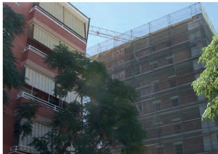
L'edifici, fronterer amb l'Alba-rosa, té tres plantes més que el del costat
