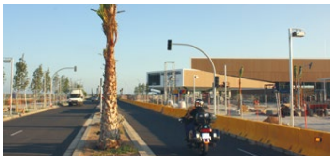
Últimos pasos de las obras en la carretera de la Vila
