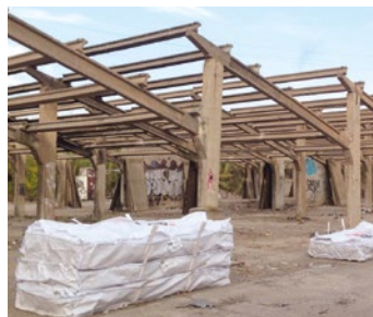
Retirada de coberta de fibrociment
