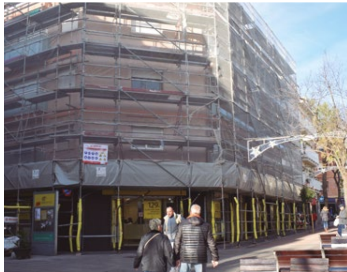
Andamios de las obras exteriores en una de las tres comunidades
