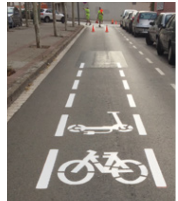
Operarios señalizan una ciclocalle
