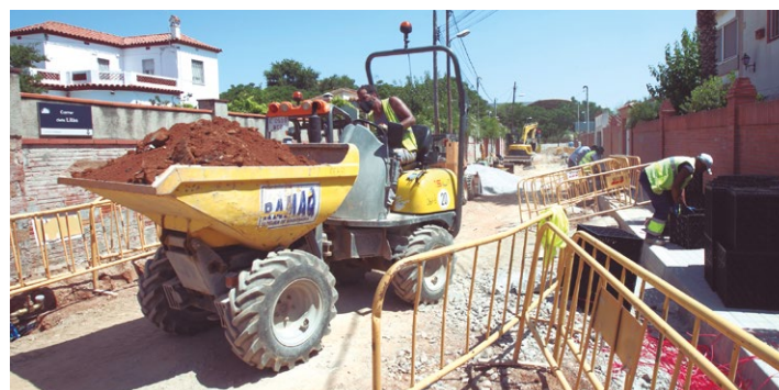
Es milloraran les voreres i el clavegueram i s'hi soterraran els cables
