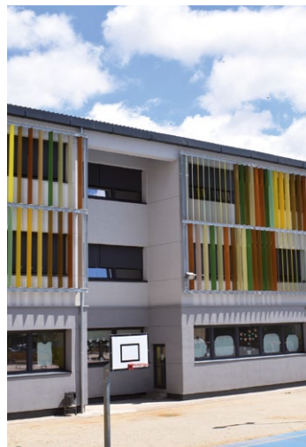
Edificio de la Escola El Garrofer
