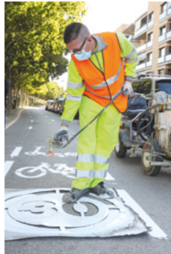
Treballs de senyalització de calçades
