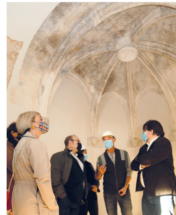
Visita a les obres al novembre
