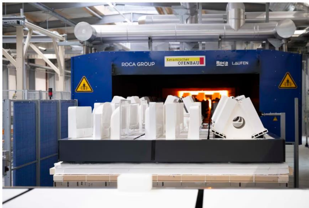
Piezas de cerámica del grupo Roca entran en el horno eléctrico que la compañía ha instalado en Gmünd (Austria). JOSEP LAGO
