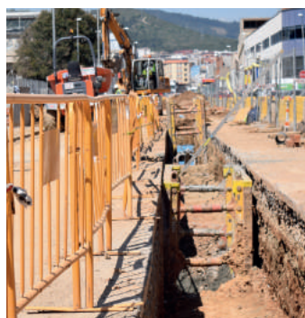
Renovació de clavegueram
