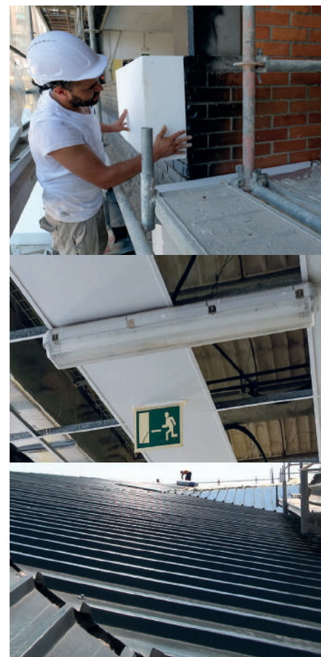
El gruix de les obres de rehabilitació es va
